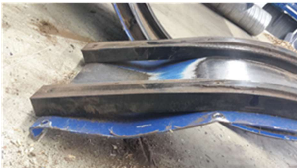
Abb. 2-8 durch Zugwirkung der Kette verformtes Gehäuseteil des Kratzkettenförderers
