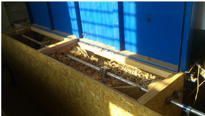
Abb. 2-12 Übergabetrog als provisorische Holzkonstruktion
