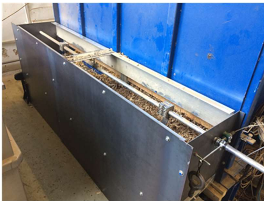
Abb. 2-13 Umbau Übergabetrog als Stahlkonstruktion
